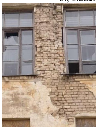
7., 8.attēls. Ārsienu mūrējuma/ frontonu bojājumi ēkas trešajā stāvā
