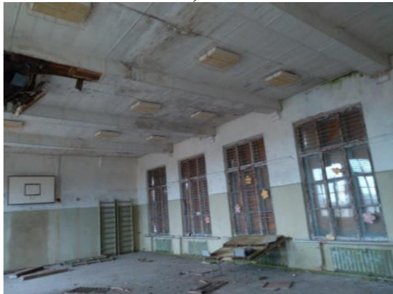
21.attēls. Iekšskats nedzīvojamās ēkas 3.stāvā (zāle)
