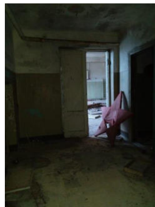
18.attēls. Iekšskats nedzīvojamās ēkas 3.stāvā
