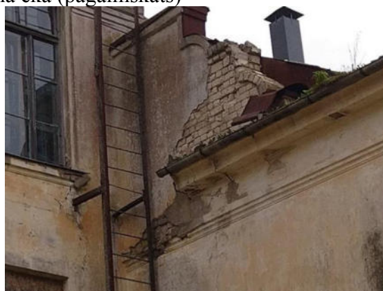
7., 8.attēls. Ārsienu mūrējuma/ frontonu bojājumi ēkas trešajā stāvā
