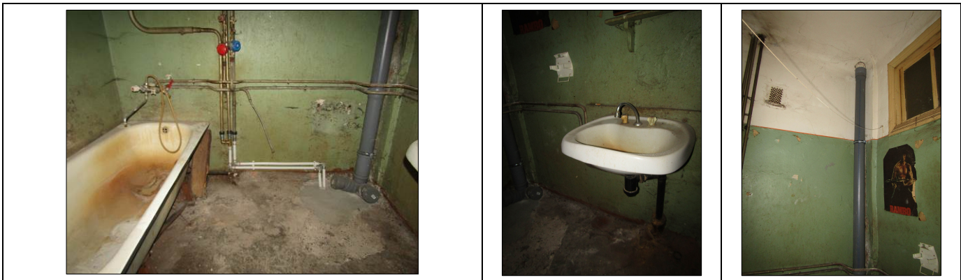
Skats uz savienoto sanitārtehnisko telpu
