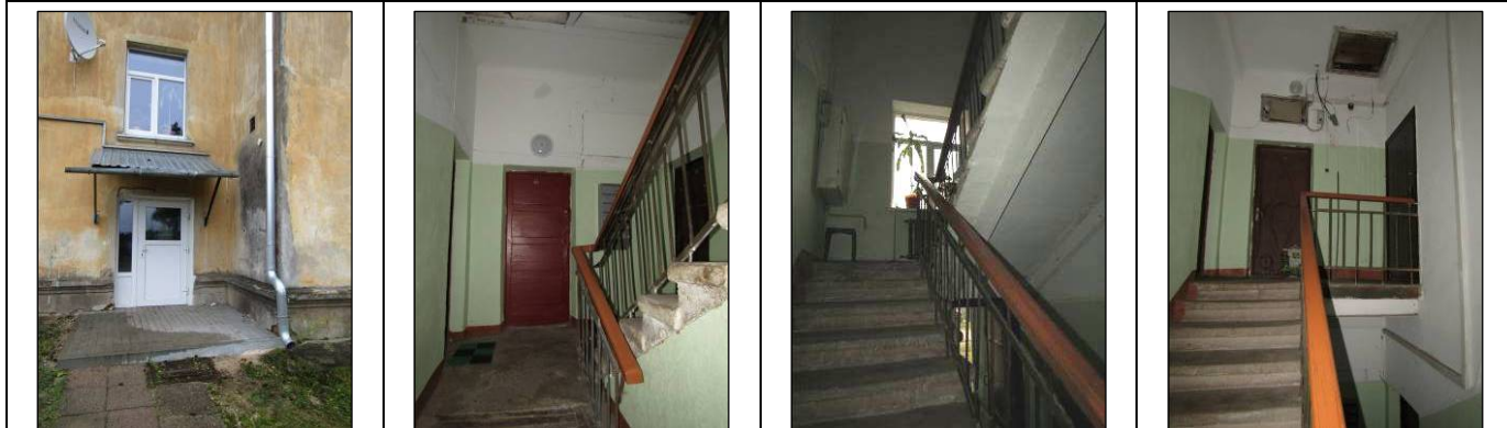
Skats uz kāpņu telpas ārdurvīm, kāpņu telpu
