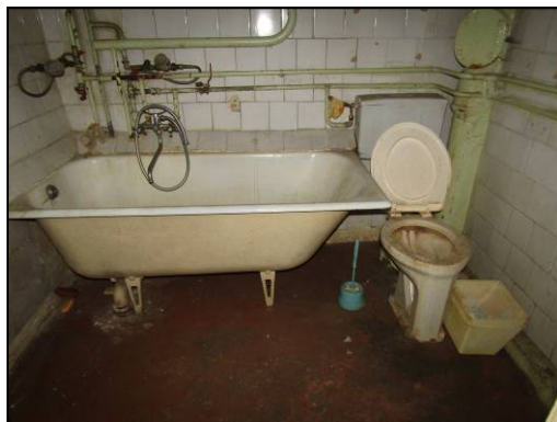
Skats uz savienoto sanitārtehnisko telpu
