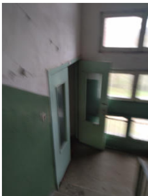
3.attēls. Kāpņu telpa
