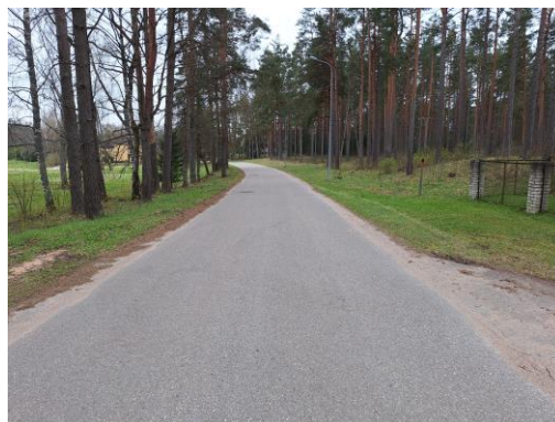
Kanalizācijas tīkli Gaujas ielā
