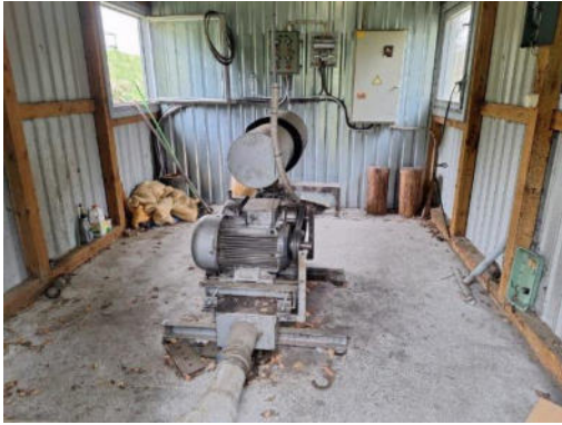
Tehniskās ēkas iekšskats
