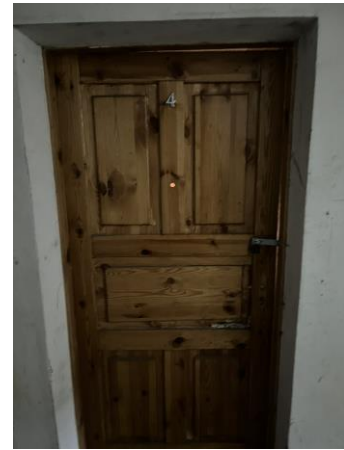
Skats uz dzīvokļa ieejas durvīm no kāpņu telpas
