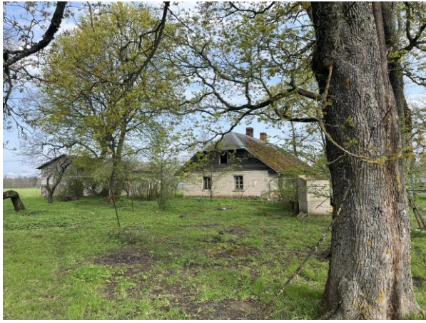
Skats uz ēku no zemes gabala teritorijas
