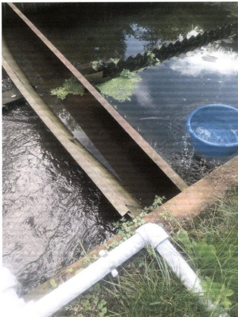
BNAI, vecās, strādā puse, dūņu līmenis par lielu, aug aļģes, nepieciešams biežāk veikt monitoringu un tehnoloģisko parametru kontroli.
