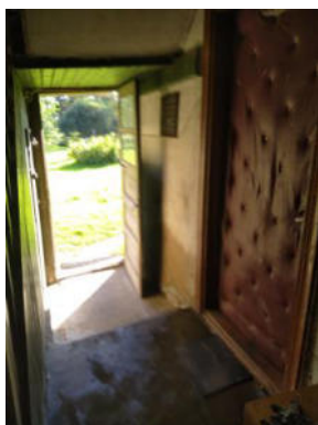
7.attēls. Ieejas durvis kāpņu telpā, kāpņu telpa
