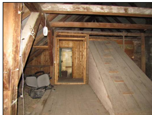
Skats uz jumta stāvu
