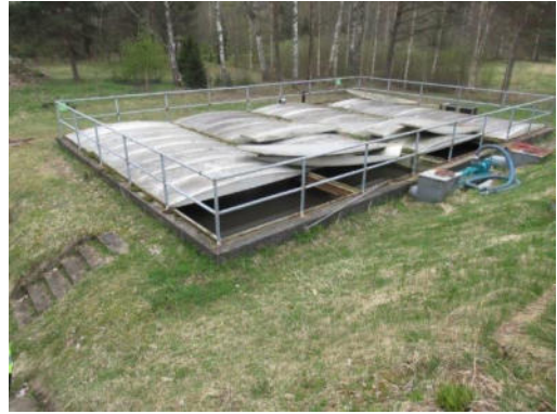
Notekūdeņu attīrīšanas iekārtas (kadastra apzīmējums 9417 001 0905 003)
