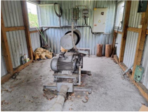
Tehniskās ēkas iekšskats
