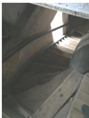
3. attēls. Kāpņu telpa
