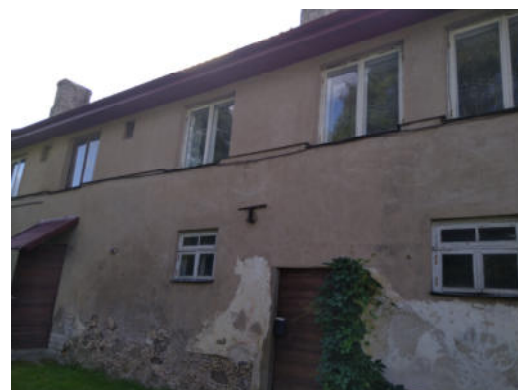
2. attēls. Dzīvojamās mājas fasāde
