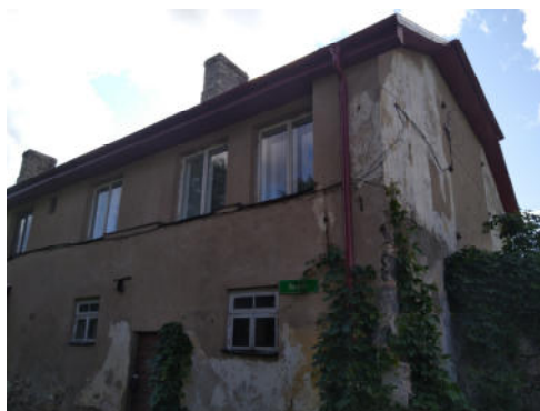
1 attēls. Dzīvojamās mājas fasāde
