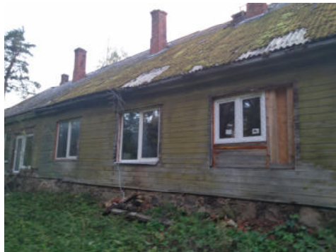
1 attēls. Dzīvojamās mājas fasāde
