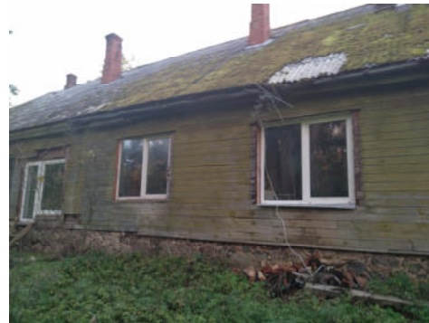
2. attēls. Dzīvojamās mājas fasāde
