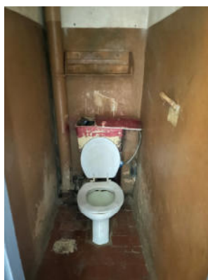
15.attēls. Tualete (telpa Nr.7)
