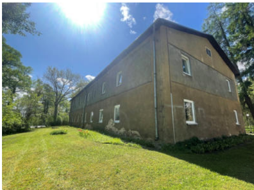
1 attēls. Dzīvojamās mājas fasāde
