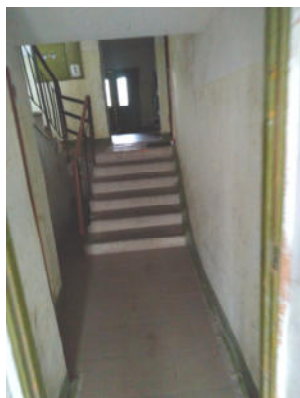
3.attēls. Kāpņu telpa
