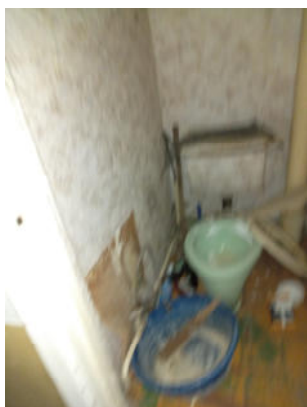
13.attēls. Tualete (telpa Nr.4)
