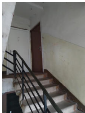
3.attēls. . Kāpņu telpa
