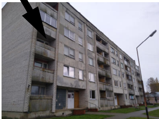
1 attēls. OBJEKTA atrašanās vieta ēkā
