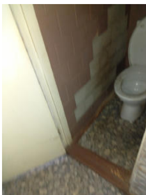
15.attēls. Tualete (telpa Nr.6)
