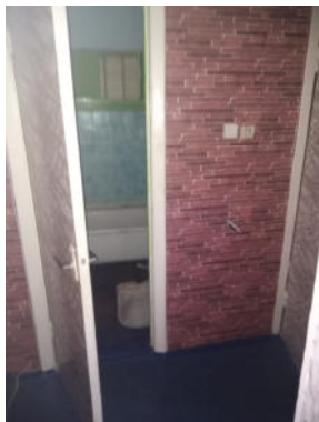
11.attēls. Skats no gaiteņa (telpa Nr.4) uz vannas istabu (telpa Nr.5)
