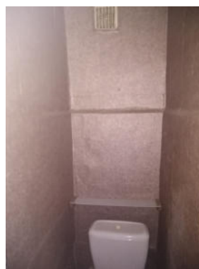
14.attēls. Tualete (telpa Nr.6)
