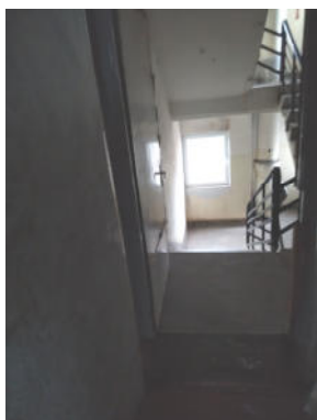
3.attēls. . Kāpņu telpa
