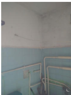
13.attēls. Tualete (telpa Nr.4)
