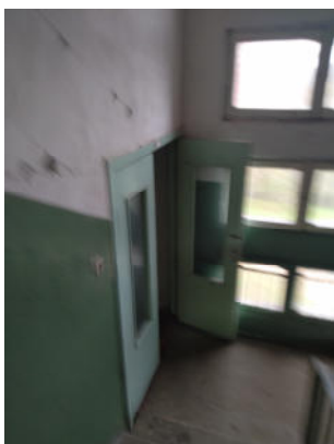
3.attēls. Kāpņu telpa
