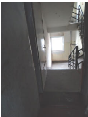
3.attēls. . Kāpņu telpa
