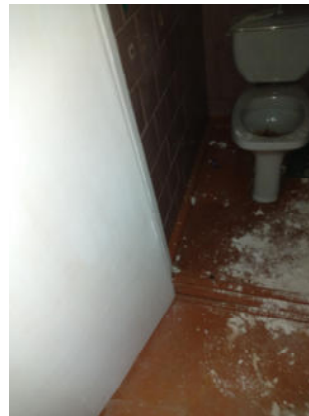
14.attēls. Tualete (telpa Nr.6)
