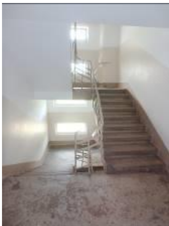
Kāpņu telpa 2.stāvā
