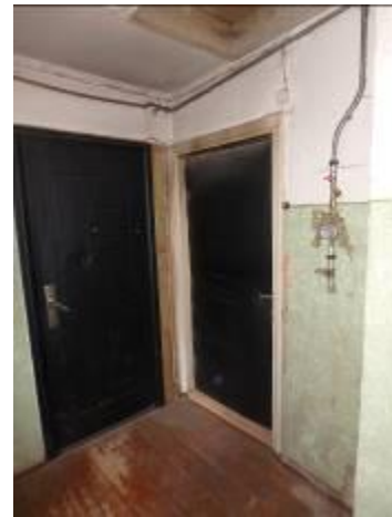
2.stāva gaitenis, skats uz dzīvokļa ārdurvīm
