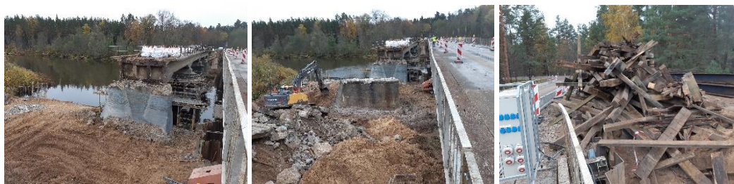
Demontēta koka daļa
