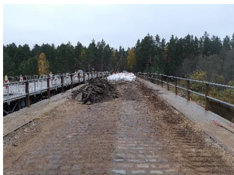
Vēsturiskā seguma demontāža, bruģakmens līdz atkārtotai ieklāšanai tiek uzglabāts maisos
