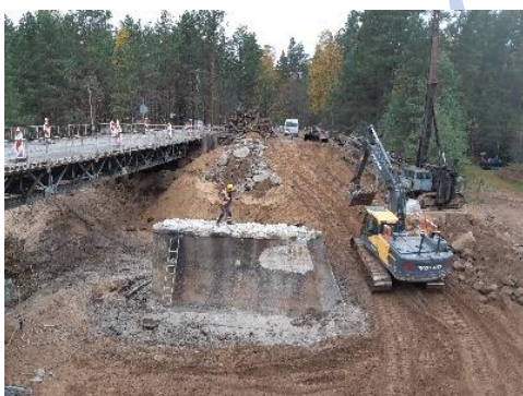
1929.gadā izbūvētā papildbalsta un krasta balsta demontāža
