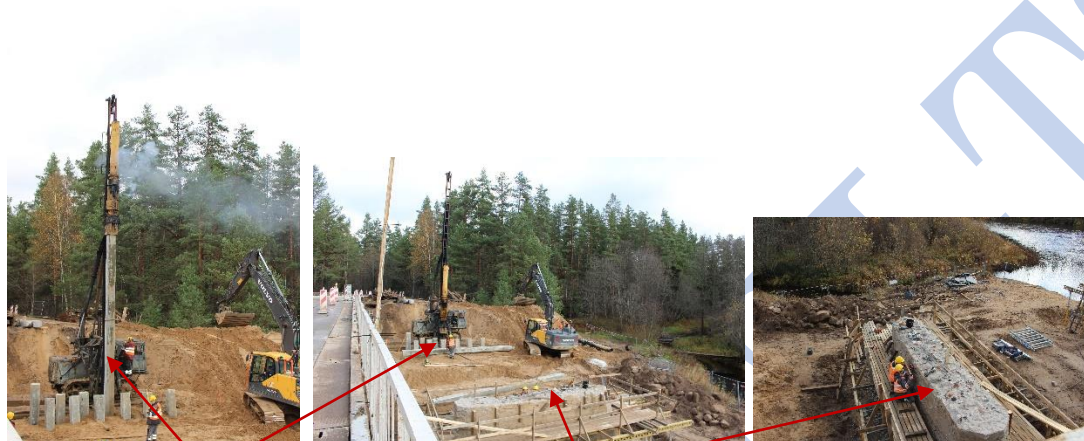
Tiek dzīti pāļi 7.balstam (krasta balsts)
