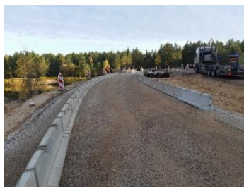
Uzbrauktuve uz pagaidu tilta
