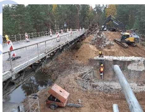
1929.gadā izbūvētā papildbalsta un krasta balsta demontāža
