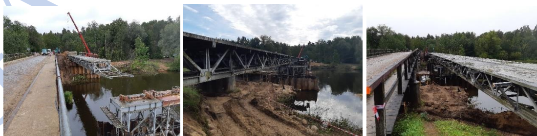
Pagaidu tilta laidumu uzbīdīšana uz balstiem
