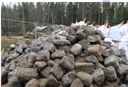
Vēsturiskā seguma demontāža, bruģakmens līdz atkārtotai ieklāšanai tiek uzglabāts maisos
