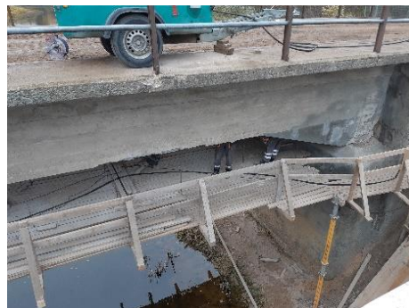
Vecu siju betona virsmas remonts
