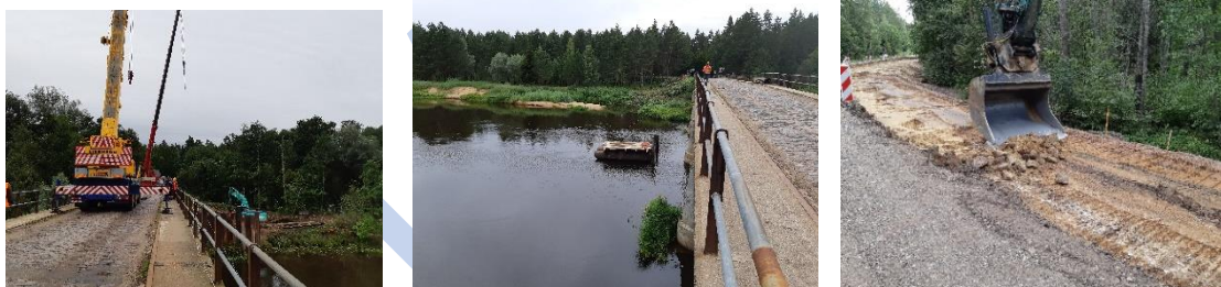
Vecā seguma demontāža
